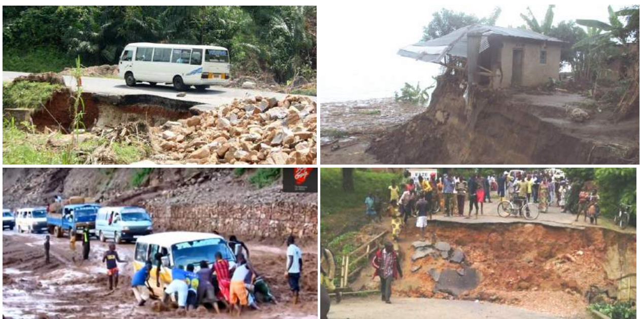
Figure 3. Photos montrant les cas d'éboulement de routes
